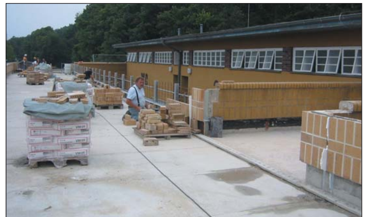
Die Länge der Brüstung erfordert eine exakte Ausrichtung des Fugenbildes
