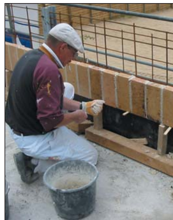
Aufmauern der Brüstung
