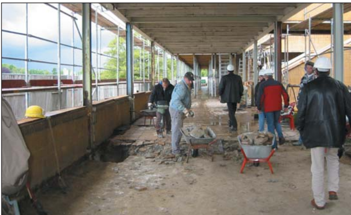
Der Unterbau des Fußbodens für den unteren Promenadenweg wird eingebracht
