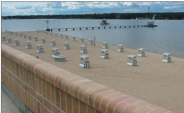
Strandbad Wannsee - die Brüstung des oberen Wandelganges ist aufgemauert
