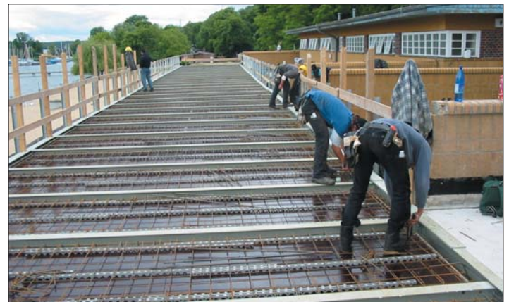
Die Stahlkonstruktion ist saniert, die Armierung für den Boden wird fertiggestellt
