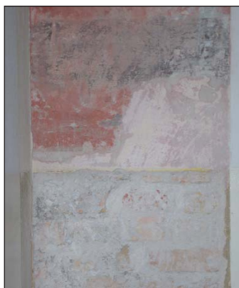
Selbst im Treppenhaus von 1934 lassen sich Ausmalungen der alten Räume des 18. und 19. Jahrhunderts nachweisen.
