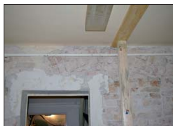
Unter dem Putz kommen die ursprünglichen Türöffnungen, oft verschoben oder zugemauert, zum Vorschein.
