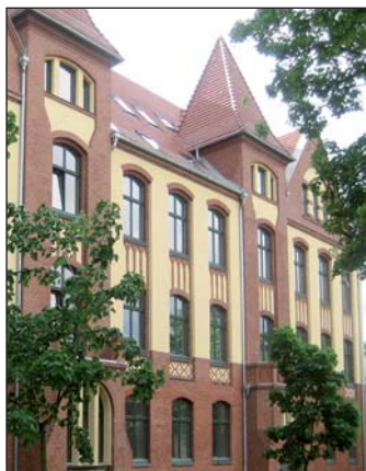
Fassade Gundelfinger Str. 10/11 nach der Sanierung in der ursprünglichen Farbgebung.
