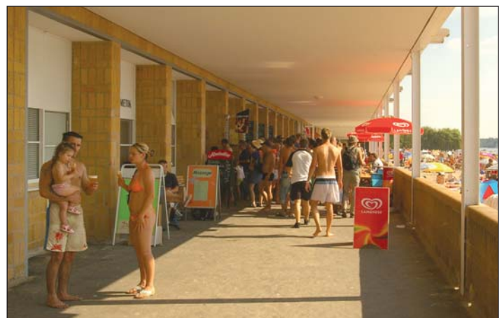
Die restaurierte Ladenzeile, die wieder dem Ursprungszustand entspricht.
