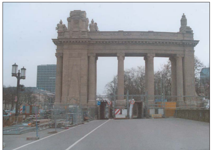
Der Südflügel des Ende Februar 2007 fertiggestellten Charlottenburger Tores.
