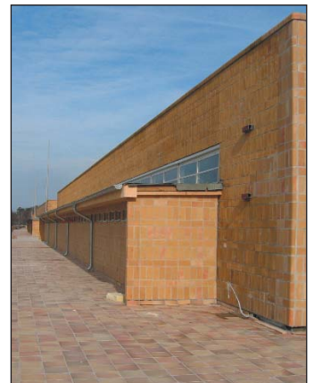
Das restaurierte Strandbad Wannsee.
