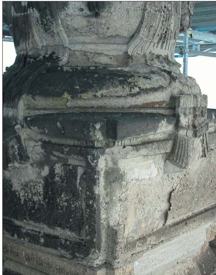
Neben der natürlichen Rückwitterung der Oberfläche heben sich Partien als kompakte Schalen ab. Die Stärke der Schale kennzeichnet die von dem Imprägnat erreichte Eindringtiefe von wenigen Millimetern.
