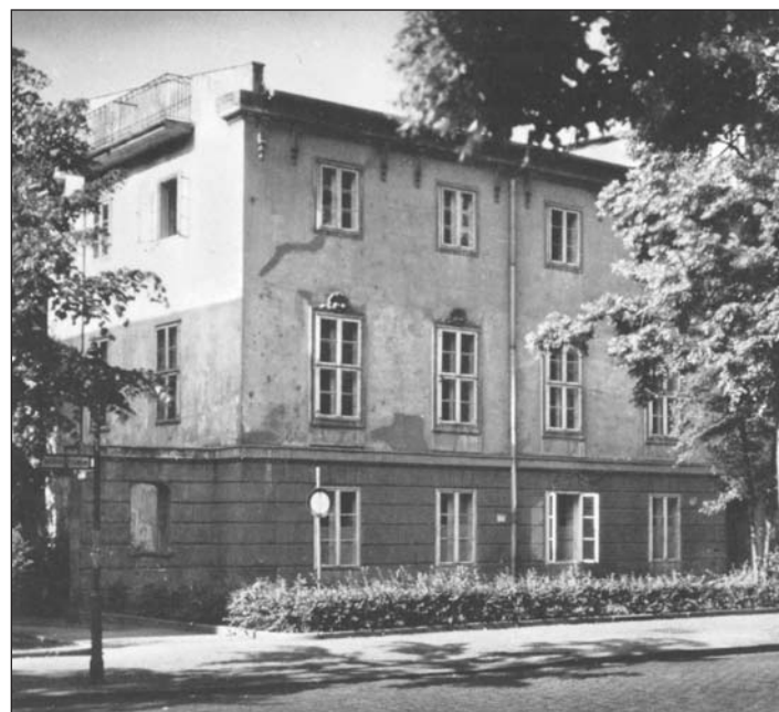
Bezirksbaudenkmal Schölerschlößchen in Wilmsdorf, aufgestockt-pflegebedürftig.
