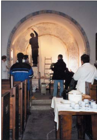
Malermeister des Kurses zum Restaurator im Handwerk bei den Freileigungsarbeiten der Malerelein im Chor.
