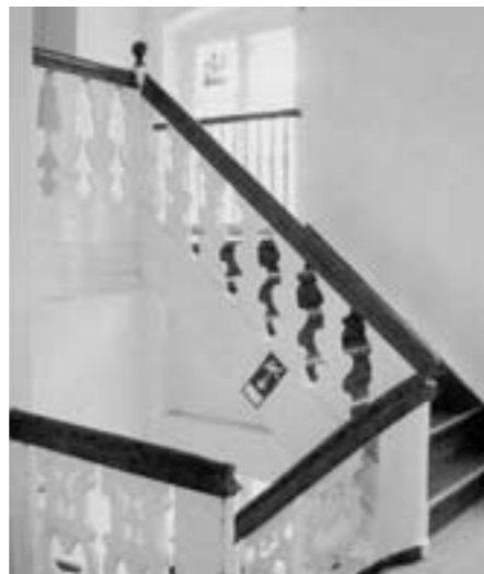
Das barocke Treppenhaus aus dem 18. Jahrhundert. Die Oberste Denkmalbehörde beim Senat verlangt absurderweise den Abbruch des abgebildeten Treppenlaufs aus dem 19. Jahrhundert.
